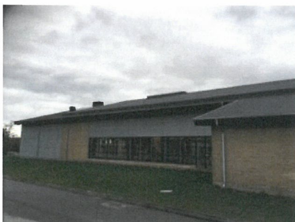
Svømmehal med sternkant af x-finerplade
