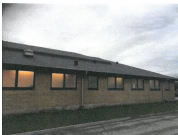
Sidebygning med sternkant af x-finerplade
