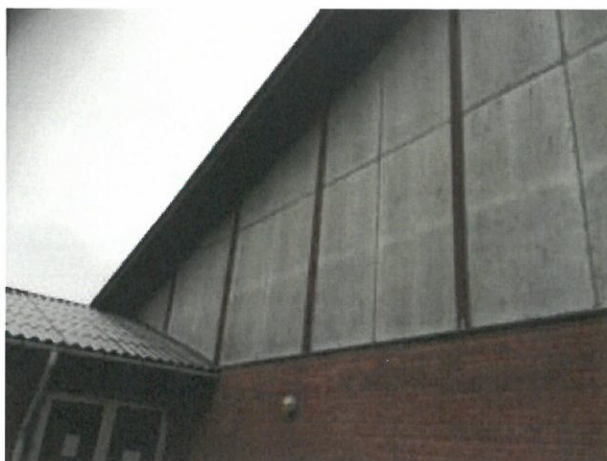
Eteritbeklædning på gavl
