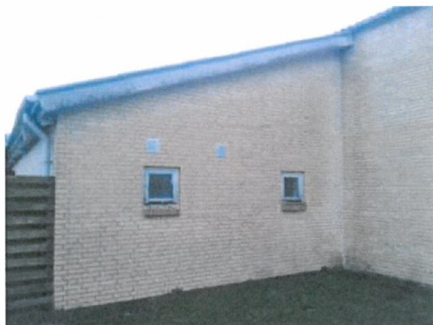
Vinduer i gavl på sidebygning
