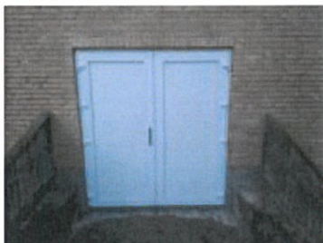
Afløb i forsænket areal ved flugtvejsdør
